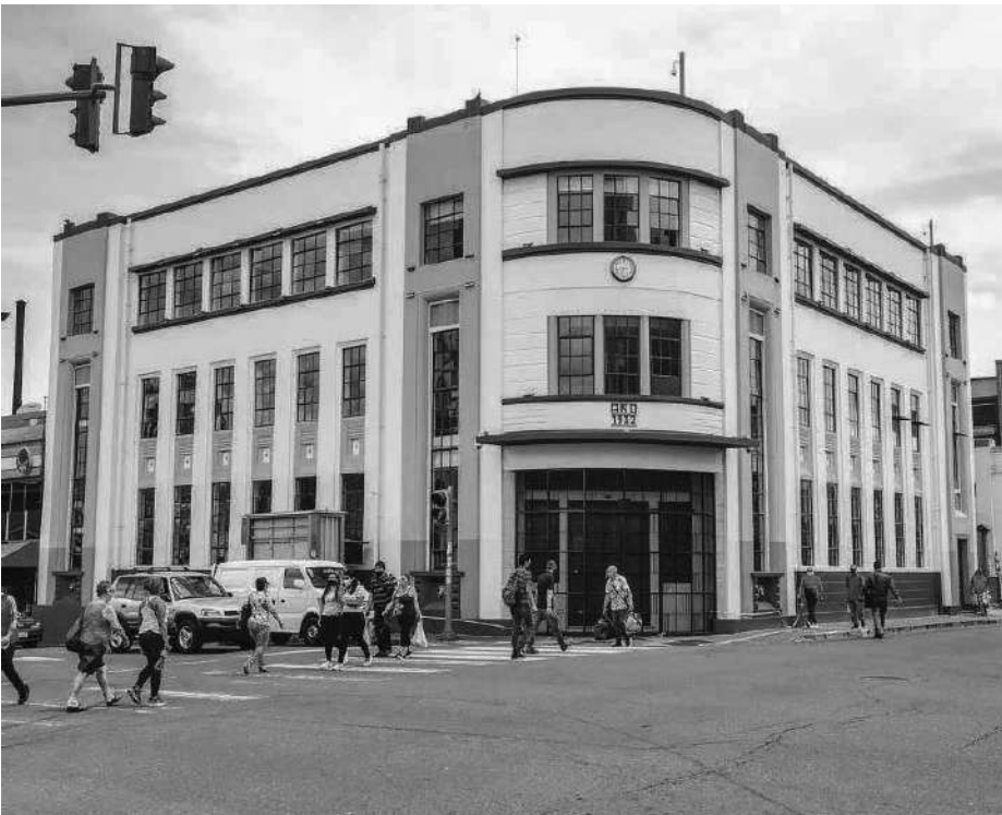
F.12. Fuente: https://www.facebook.com/ChepetownCR/photos/la-antigua-estaci%C3%B3n-de-bomberos-de-san-jos%C3%A9-una-joya-restaurada-recipientementeche/923502761496375/?locale=es_LA
